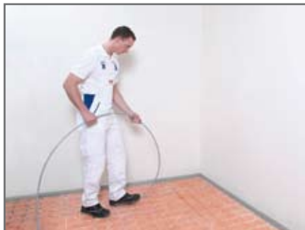
Einklicken des Heizrohres
